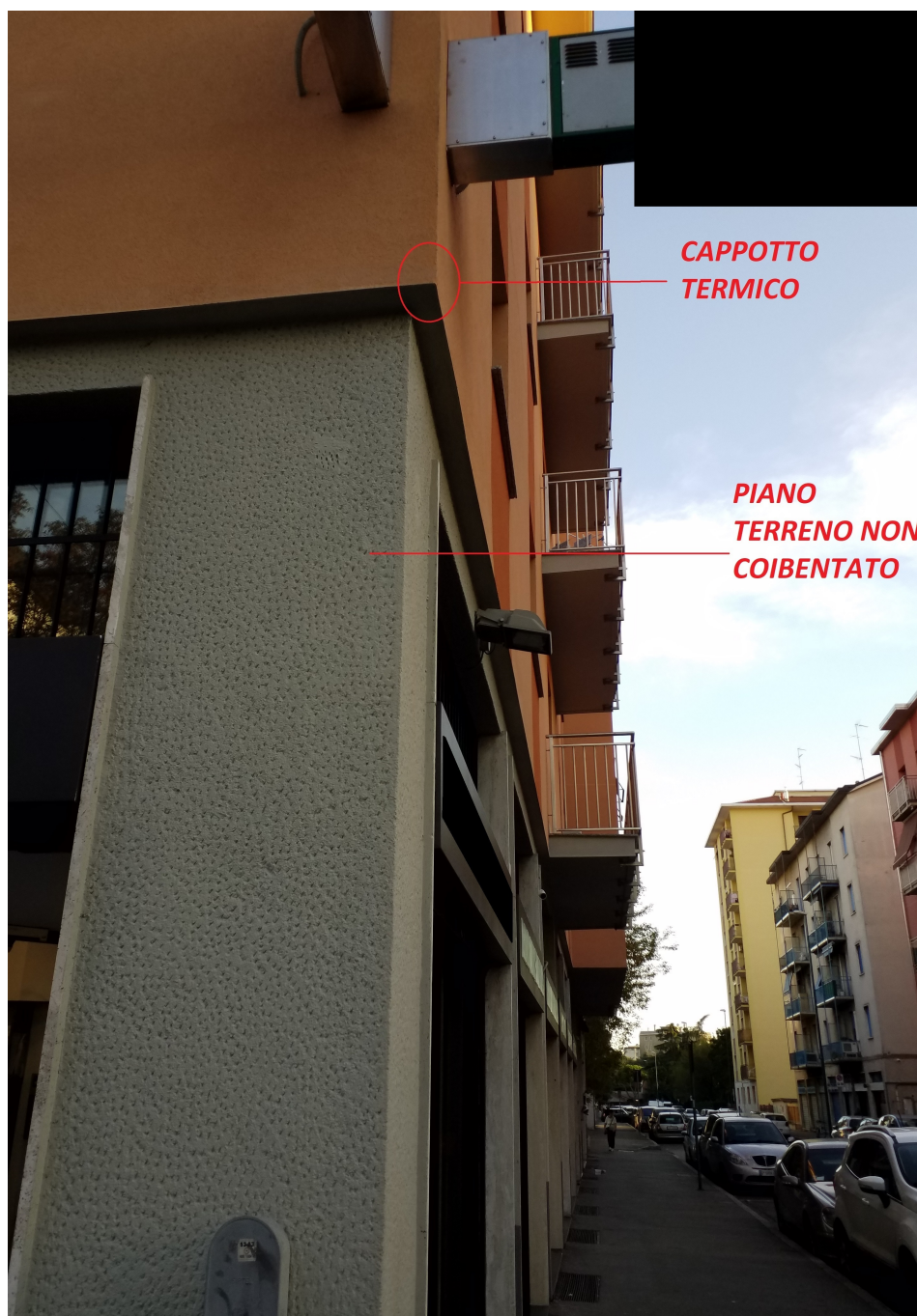
Figura 3. Errore n. 1: non coibentare tutti i piani riscaldati
