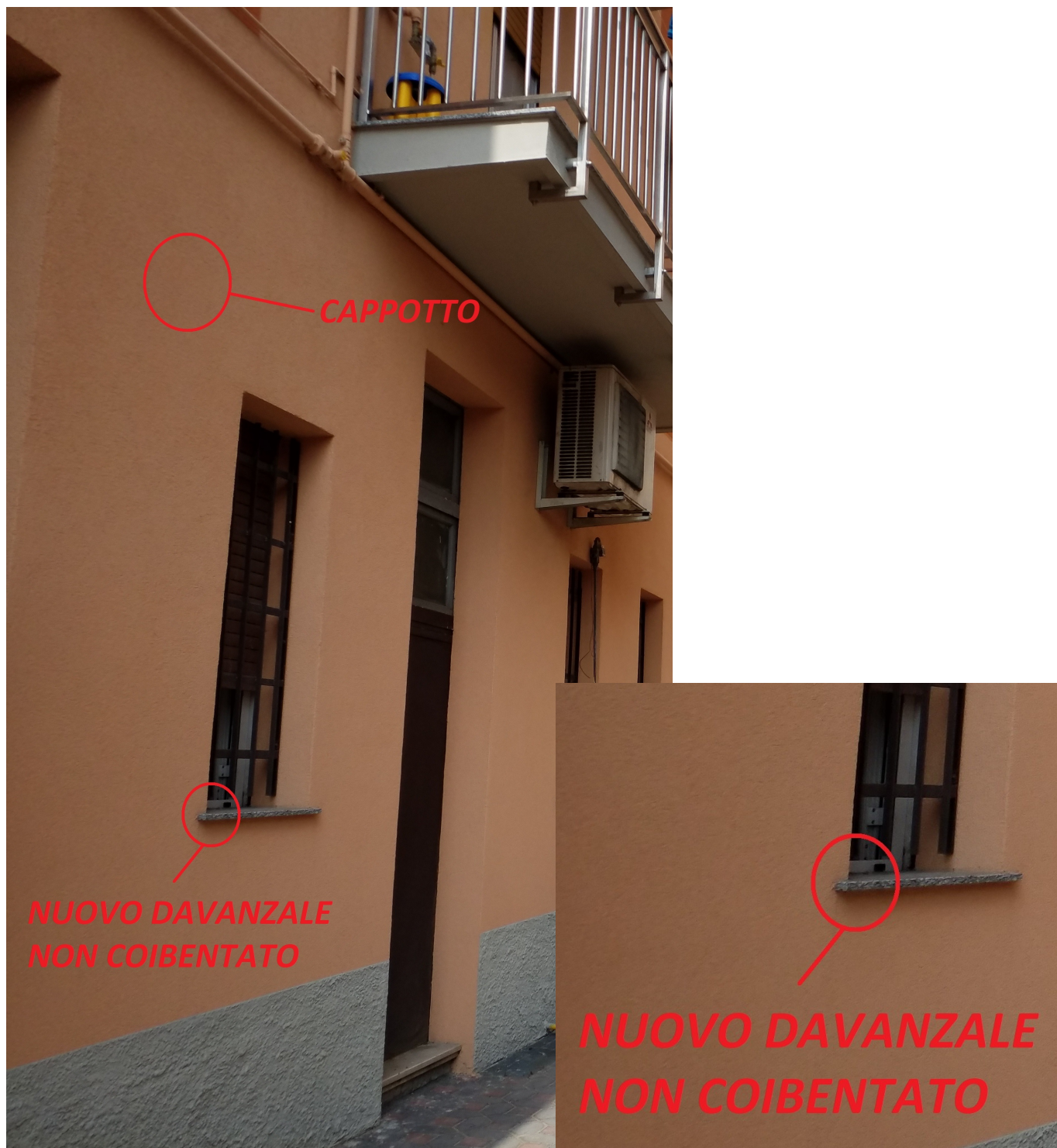
Figura 5. Errore n. 3: installare davanzali e soglie non coibentati
