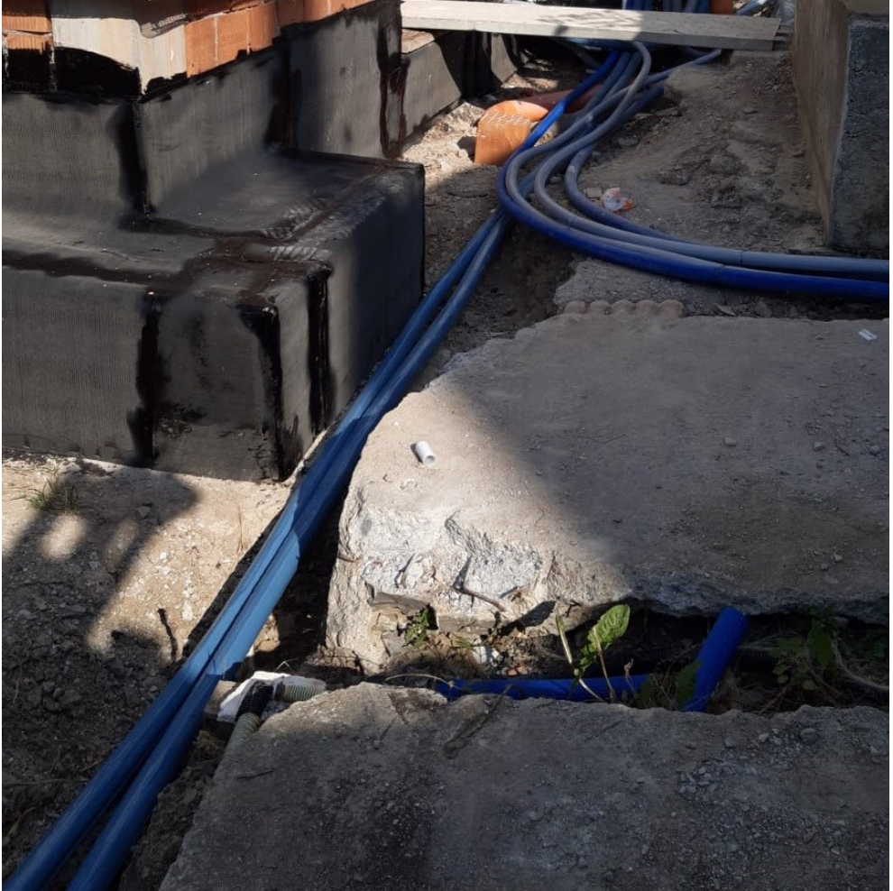
Figura 5 – Impermeabilizzazione di travi e plinti di fondazione, mediante posa in opera di due strati di guaina bituminosa elastoplastomerica da 4 mm, applicati a teli sfalsati. La guaina è stata posata in totale aderenza sulle strutture di fondazione e sulle pareti in laterizio, fino ad un'altezza di circa 30 cm fuori terra. Prima dell'applicazione della guaina, le superfici delle pareti in laterizio sono state rese planari mediante la realizzazione di uno strato di livellamento in malta cementizia, inoltre, su tutte le superfici di posa della guaina, sono state preventivamente stese due mani di primer bituminoso, avente funzione di promotore di adesione.
