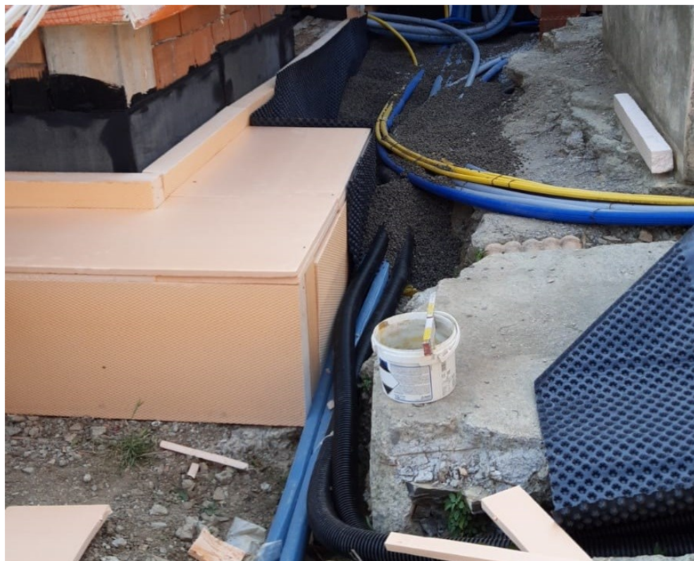
Figura 6 -- Isolamento termico di travi e plinti di fondazione, mediante posa in opera di pannelli in XPS, protetti con membrana bugnata. L'incollaggio dei pannelli in XPS è avvenuto mediante l'impiego di impermeabilizzante elastico bicomponente, idoneo alla posa su supporto bituminoso.
