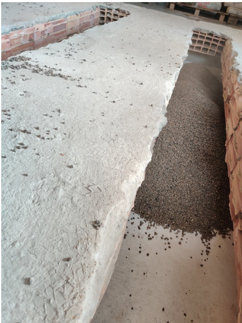
Figura 10 – Intervento di coibentazione di solaio contro terra esistente, realizzato mediante demolizione parziale della caldana e delle pignatte di alleggerimento del solaio, rimozione del ghiaione sottostante e creazione di un “vespaio” in argilla espansa, posato su di uno strato di tessuto non tessuto.
