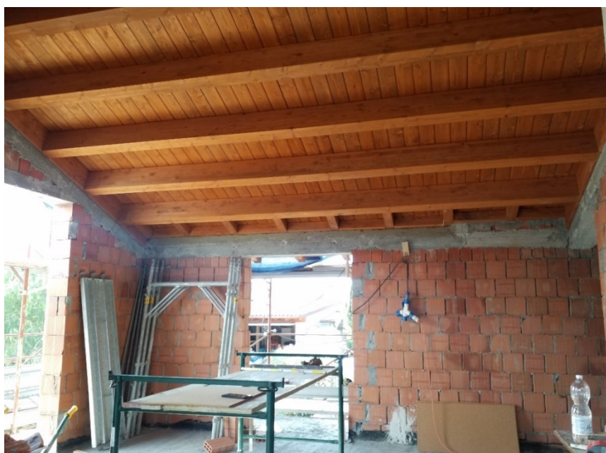
Figura 19 - Tetto ventilato - Vista interna
