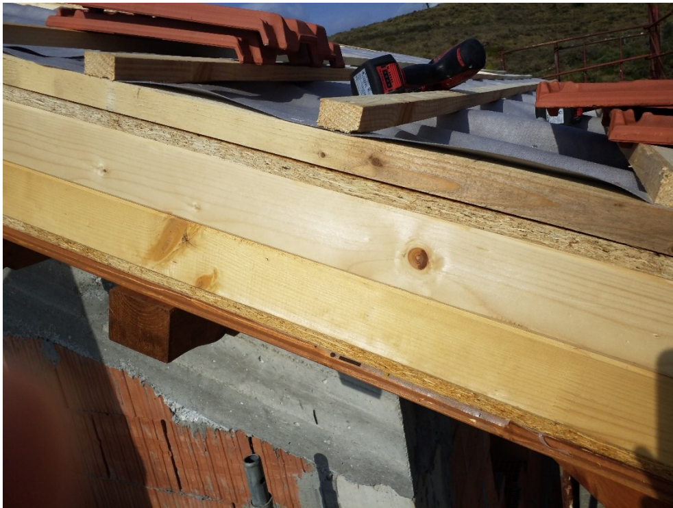
Figura 17 - Tetto ventilato - Listelli di contenimento perimetrali
